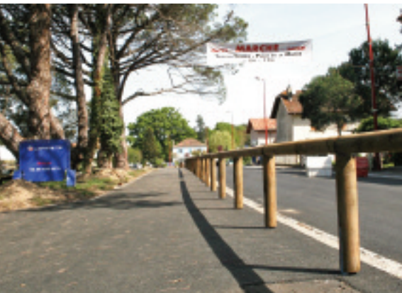
La voie verte longe la route départementale traversant le bourg
