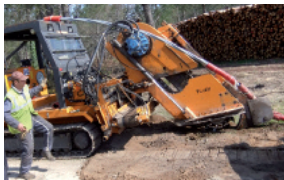
ERDF dispose de machines qui creusent, enfouissent et recouvrent
